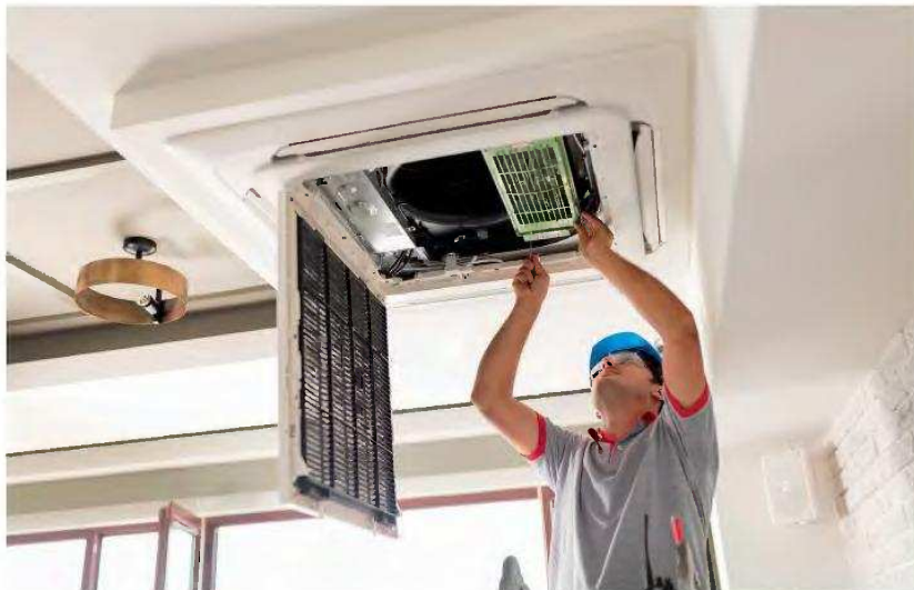
Η συστηματική λήψη κατάλληλων μέτρων για τη σωστή λειτουργία των υδραυλικών και κλιματιστικών εγκαταστάσεων μειώνει τον κίνδυνο μετάδοσης βακτηριδίων του γένους legionella, ιδιαίτερα σε χώρους όπως ξενοδοχεία, αθλητικές εγκαταστάσεις, νοσοκομεία και κρουαζιερόπλοια.
